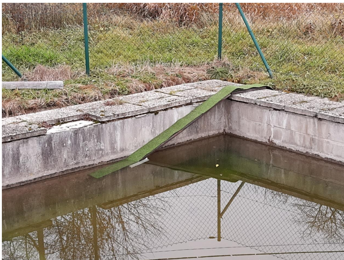
Obr.: Sklopná rampa v Proseči umožňuje čištění nádrže a její sklon se díky plováku a kloubu mění s výškou hladiny.
