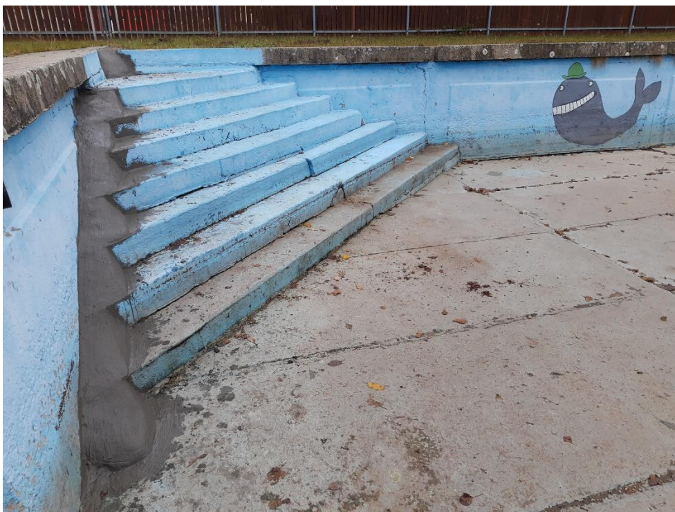
Obr.: Betonový výlez na koupališti ve Všelibicích umožní žabkám opustit nádrž před čištěním koupaliště na začátku července.
